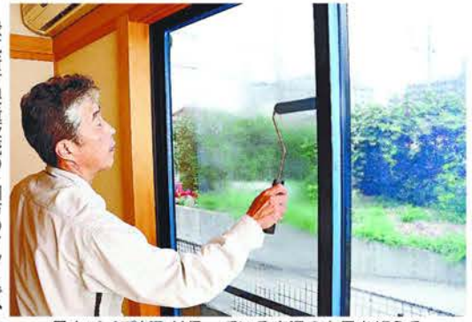
日本パイプが取り扱っている室温の上昇を抑えるコーティング剤の塗装作業 (広島市佐伯区)
